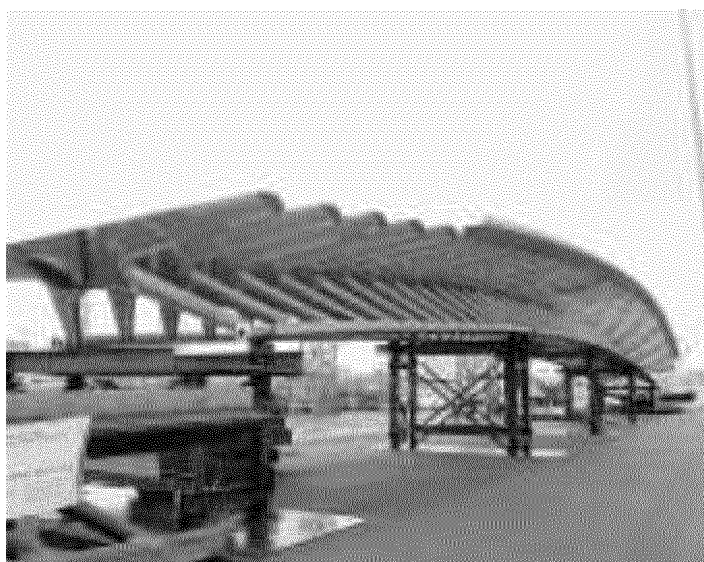
Lo scheletro del ponte di Calatrava in cantiere
